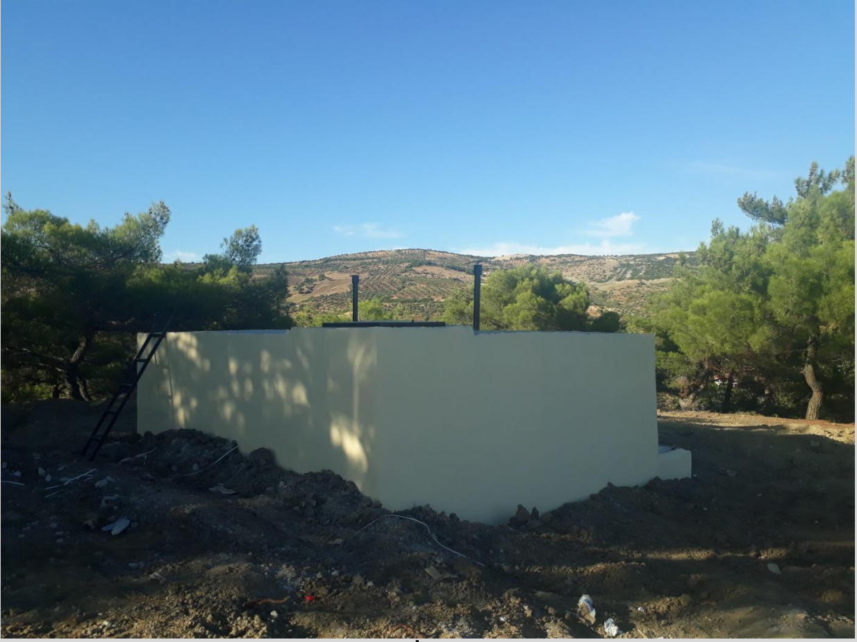
Körahmethöyüğü-Kocalar Mzr. 50 Tonluk İçmesuyu Deposu
