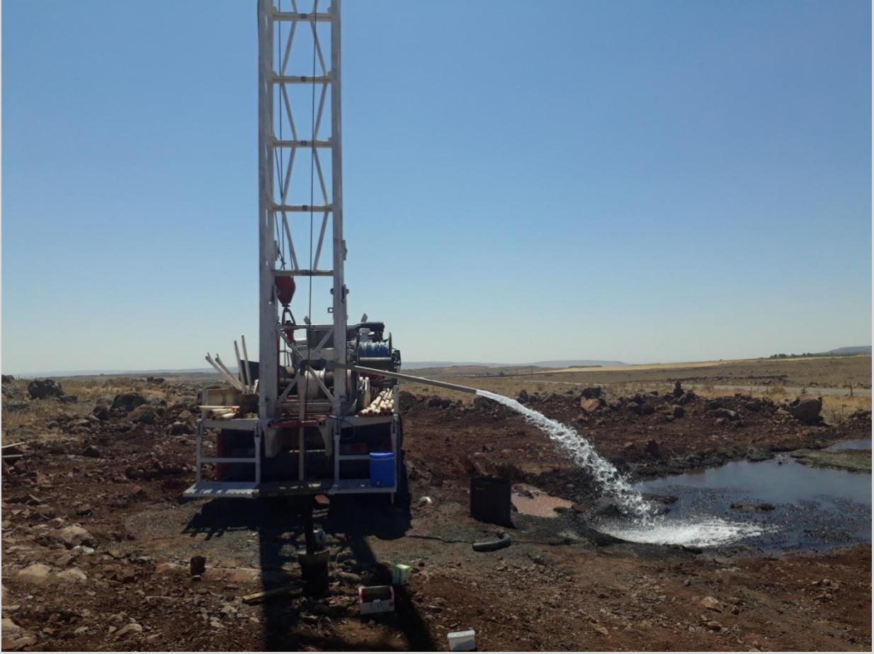
Yılanca-Karapınar Mzr. Sondaj Deneme Çalışması
