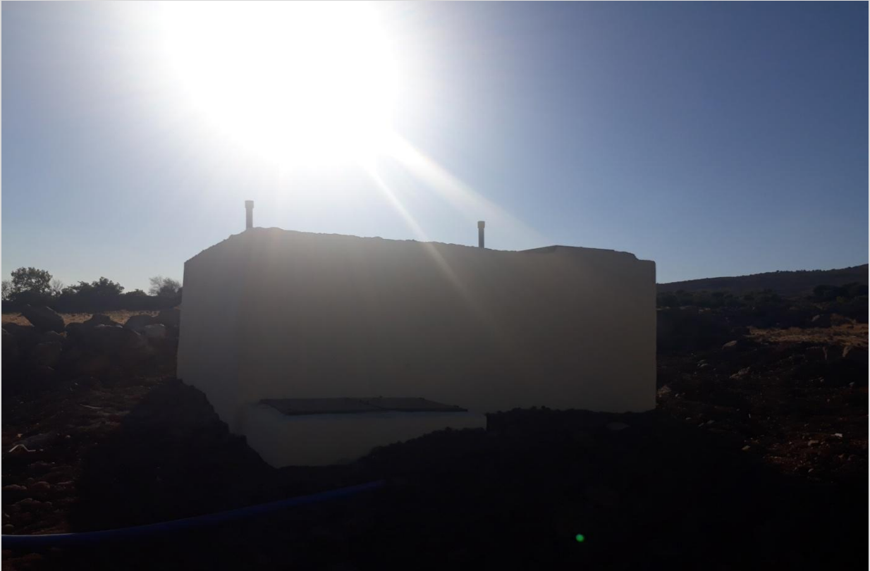
Kolpınar Köyü 50 Tonluk İçmesuyu Deposu
