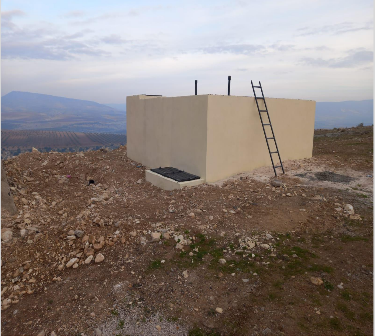
Demirciler Köyü 50 Tonluk İçmesuyu Deposu
