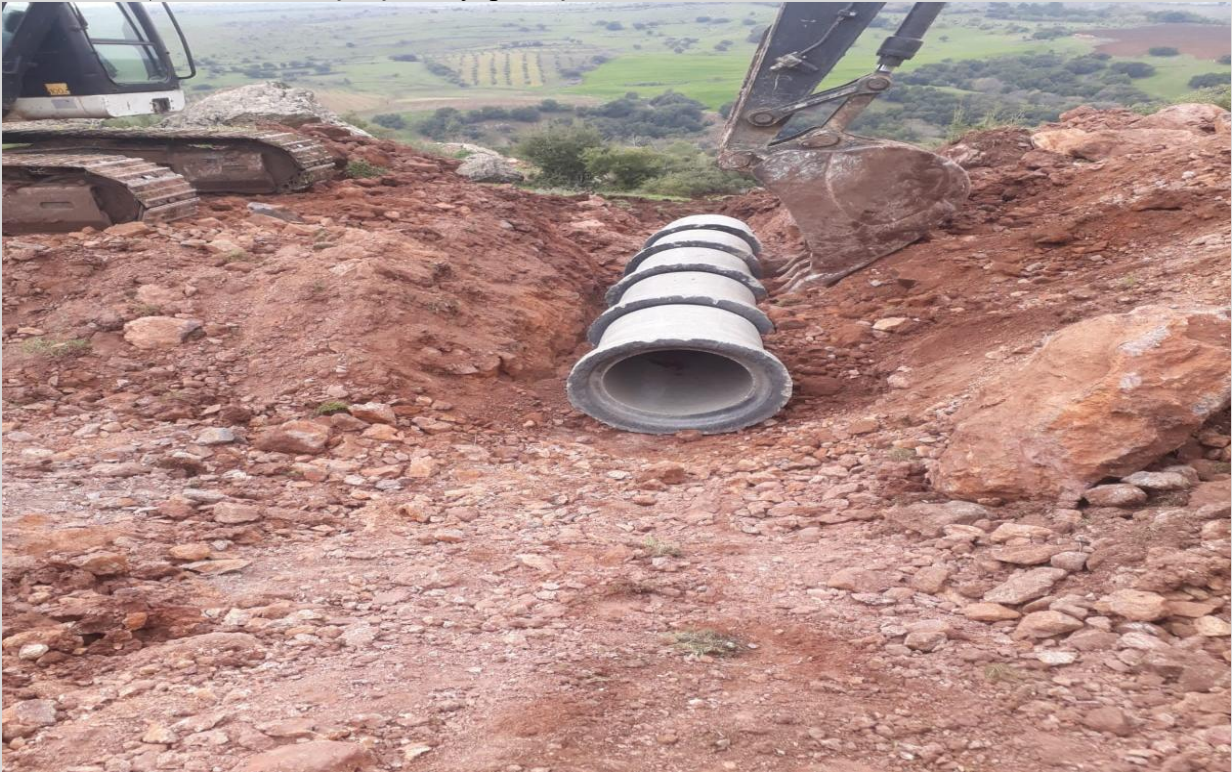
Dümbüllü Köyü Büz Boru Çalışması
