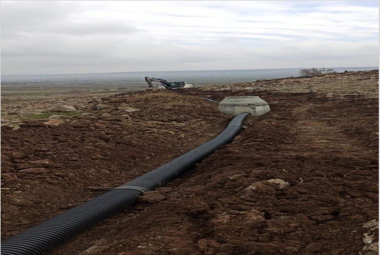
Küçükkonak Köyü Kanalizasyon Hattı Çalışması
