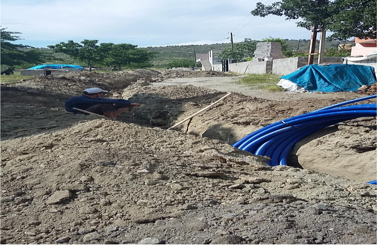
Mağaracık Köyü İçmesuyu Hattı Çalışması
