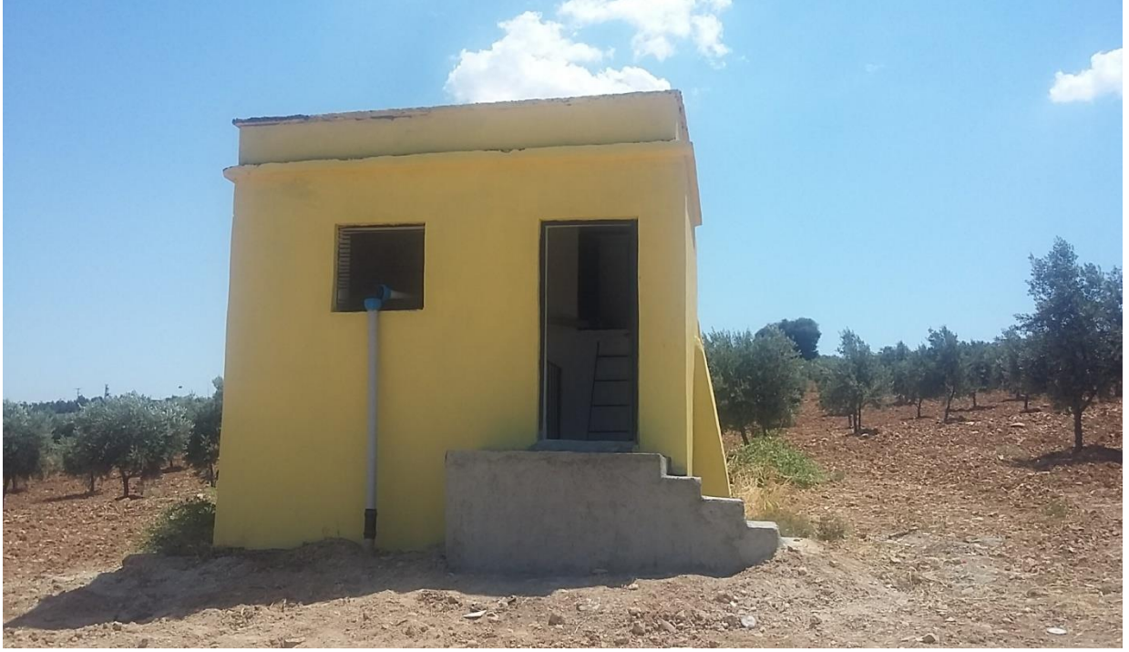
Saatli-Otluca Mzr. İçmesuyu Deposu Bakım Onarım Çalışması
