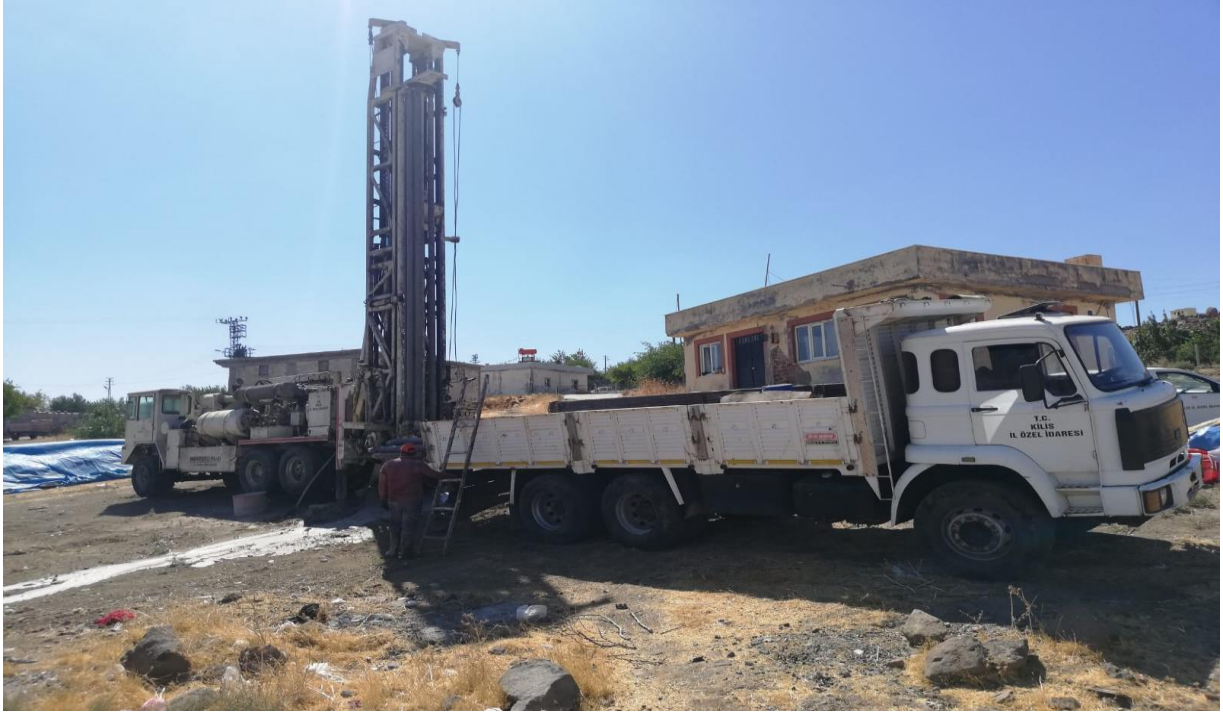
Küçükkonak Köyü Sondaj Çalışması
