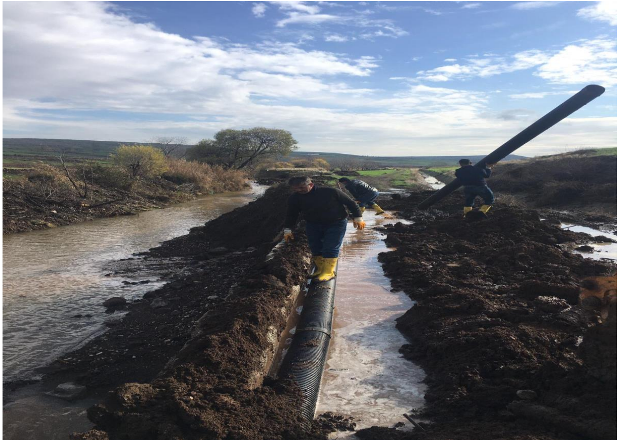
Yeniyapan Köyü Kanalizasyon Çalışması
