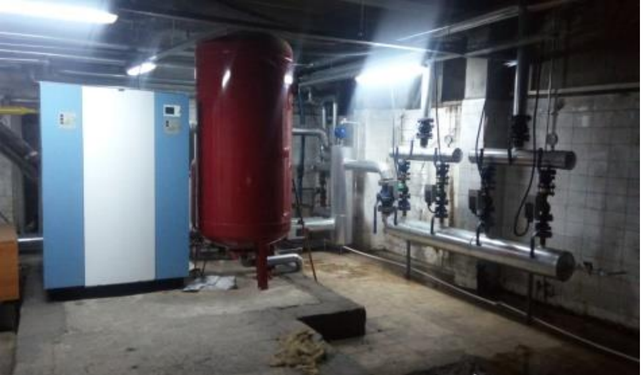
Süleyman Demirel Ortaokulu Doğalgaz Dönüşüm işi
