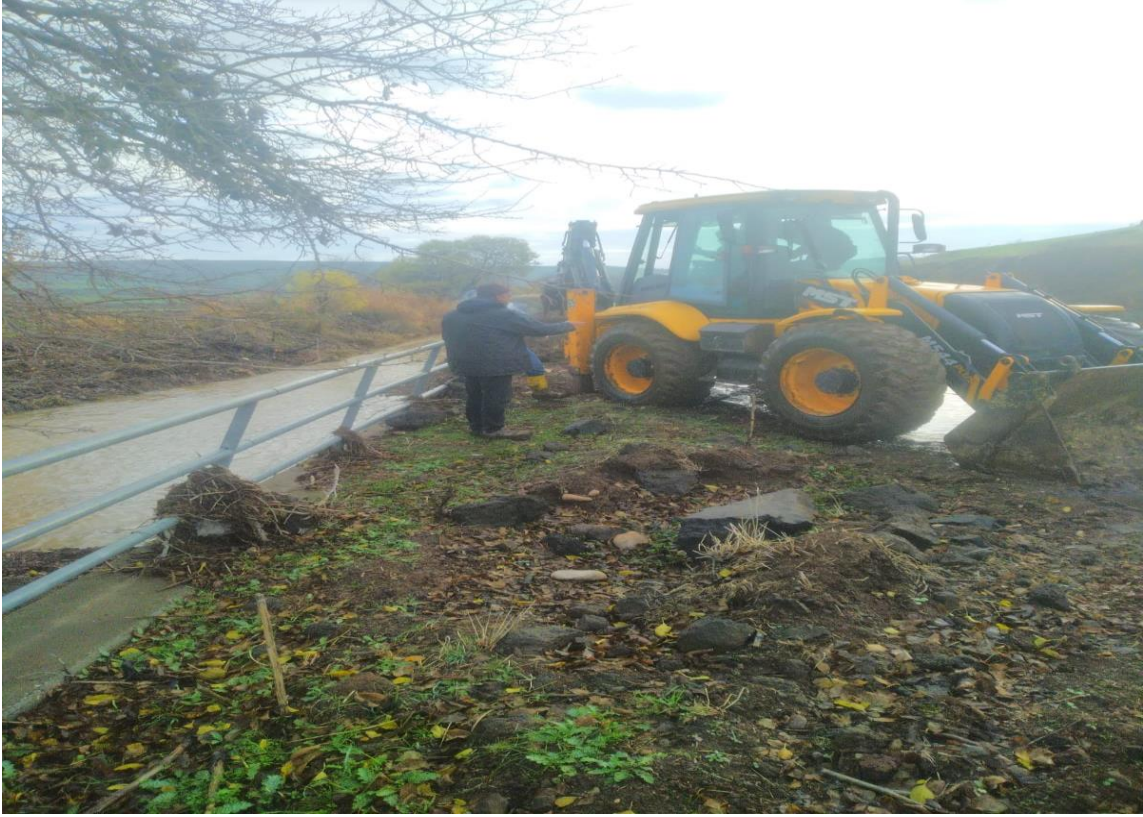
Polatbey Köyü Kanal Temizliği
