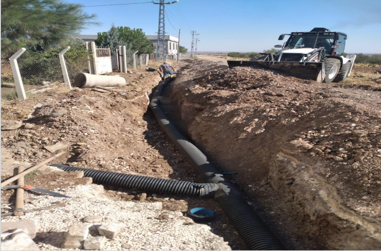
Erikliyayla Köyü Kanalizasyon Hattı Çalışması
