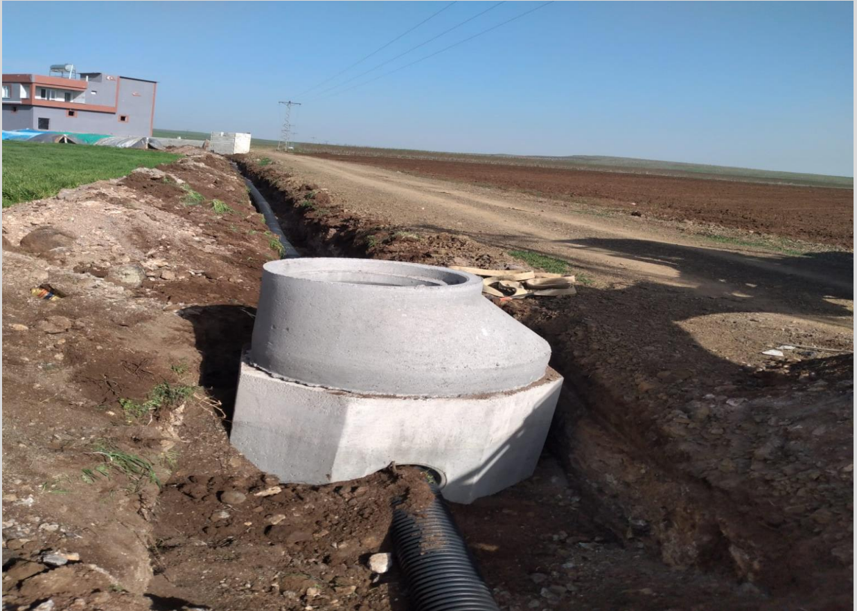
Güvenli Köyü Kanalizasyon Hattı Çalışması
