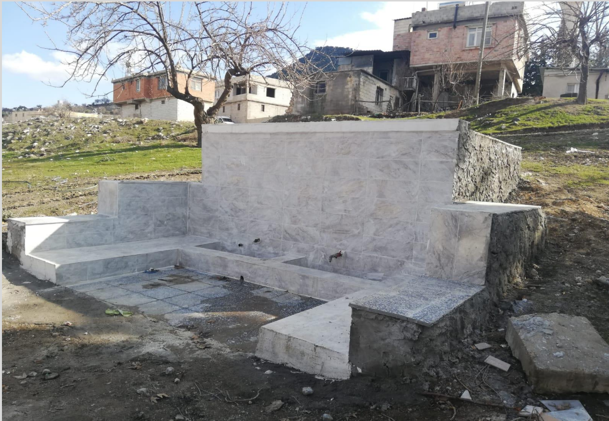
Tokaçgemriği Köyü İçme Suyu Depo Bakım Onarım
