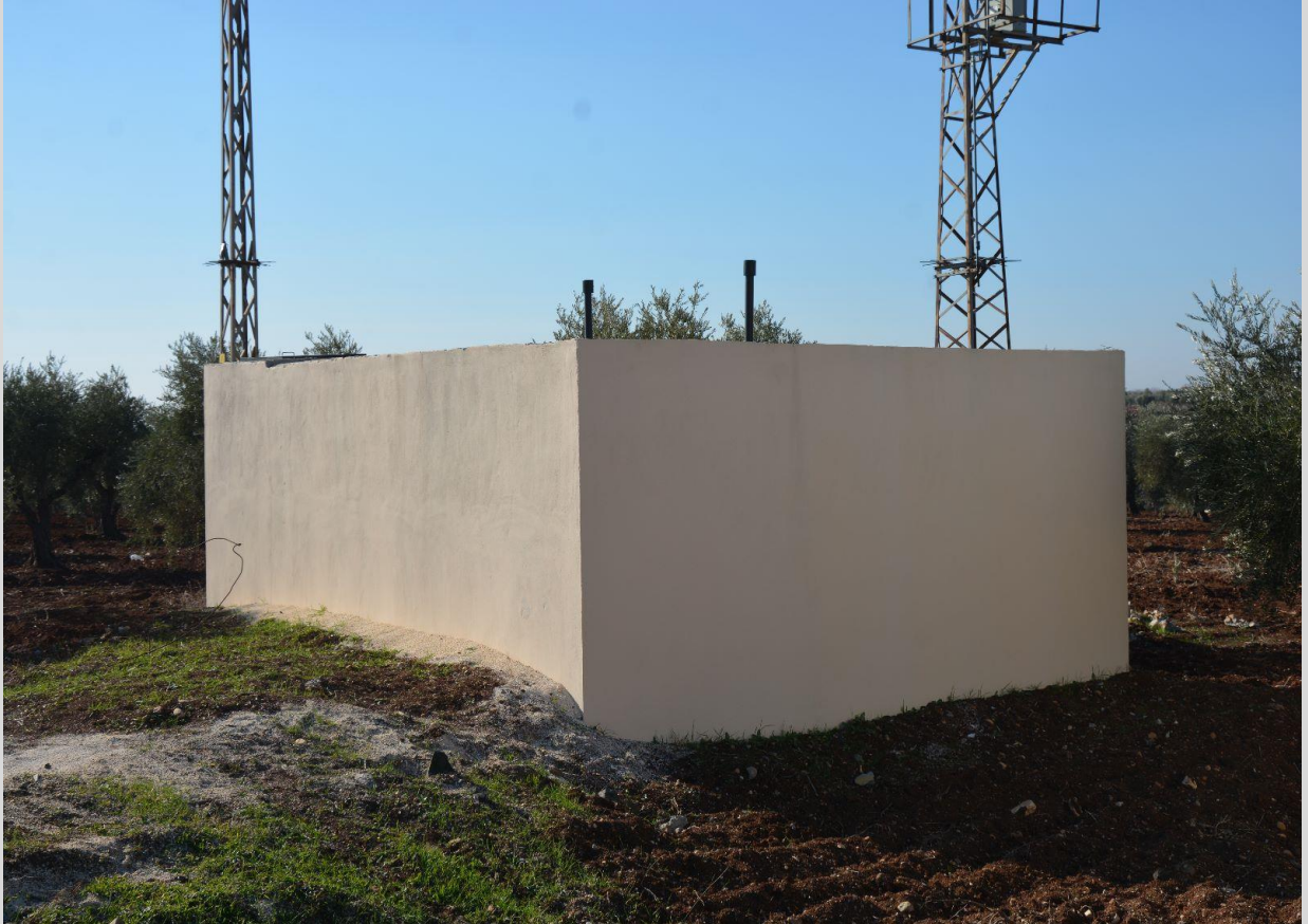
Arpakesmez Köyü 100 Tonluk İçme Suyu Deposu
