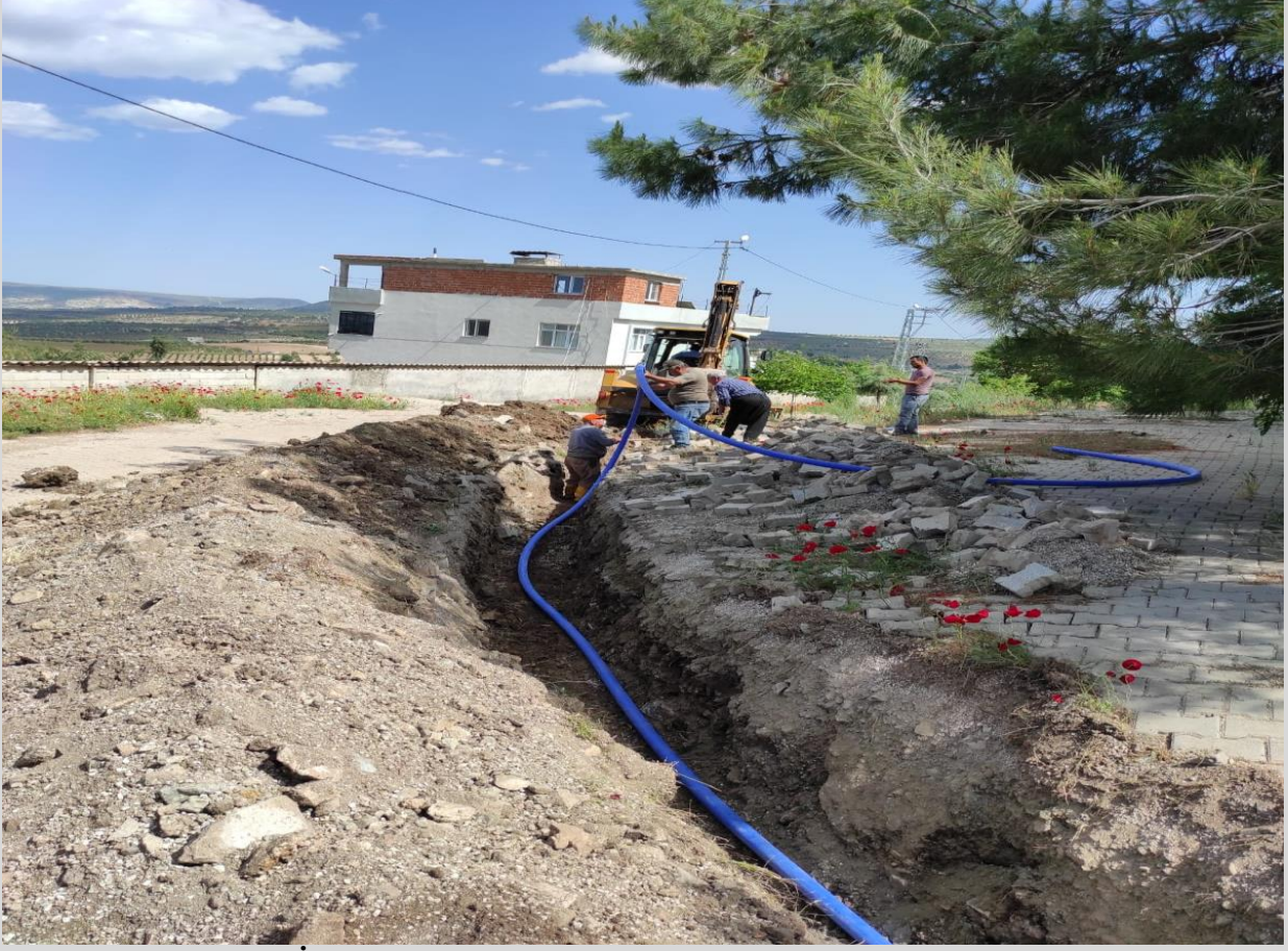
Aşağı bademli Köyü İçme Suyu Terfi Hattı Çalışması
