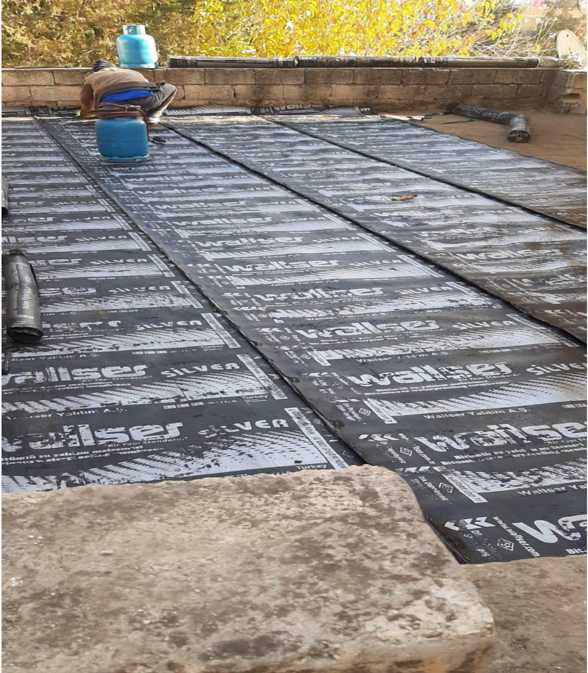
Şehit Sakıp Ortaokulu Teras Yalıtım İşi
