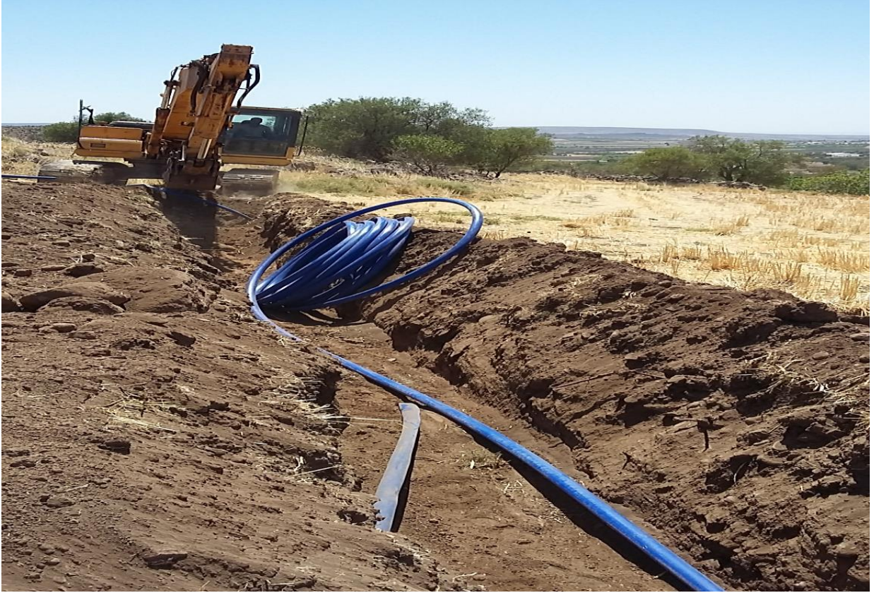
Fericek Köyü İçmesuyu Hattı Çalışması
