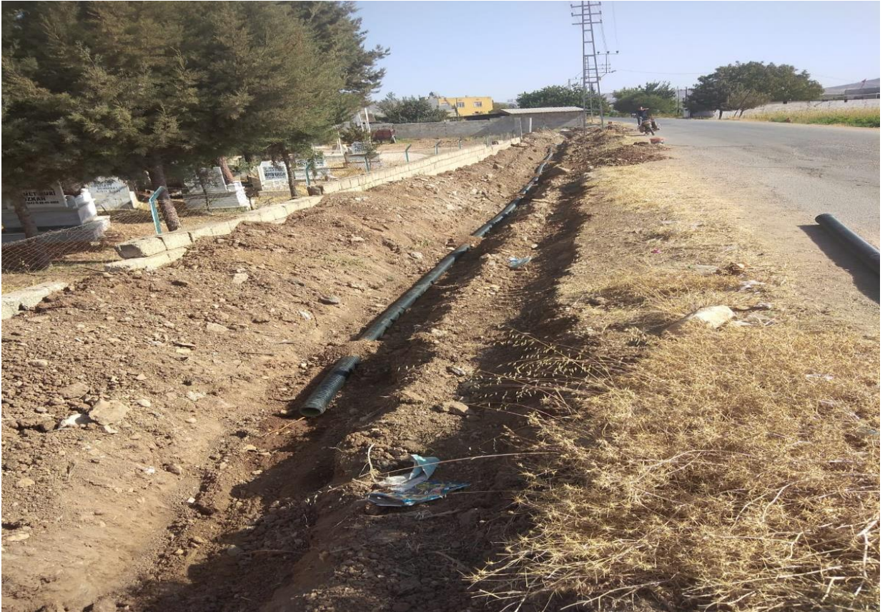
Duruca Köyü Kanalizasyon Hattı Çalışması
