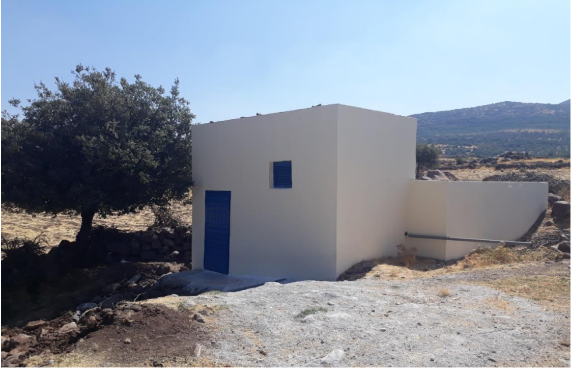
Bulamaçlı Köyü İçmesuyu Deposu Bakım Onarım İşi
