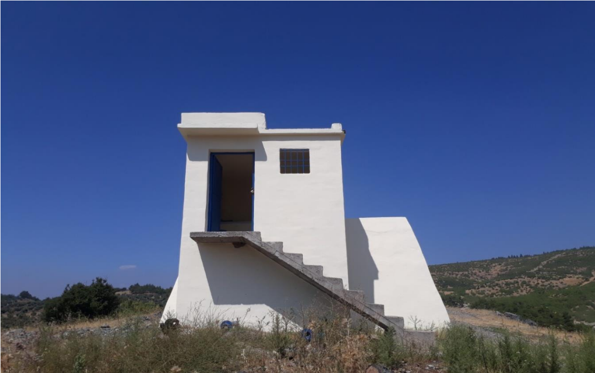
Gülbaba Köyü İçmesuyu Deposu Bakım Onarım İşi
